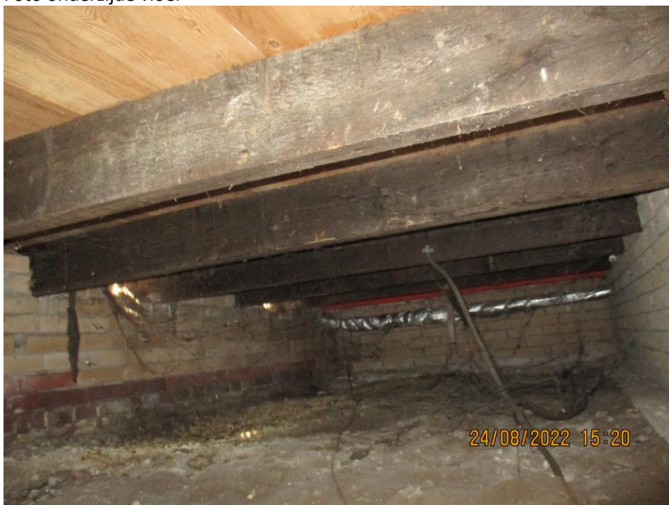
Foto onderzijde vloer
